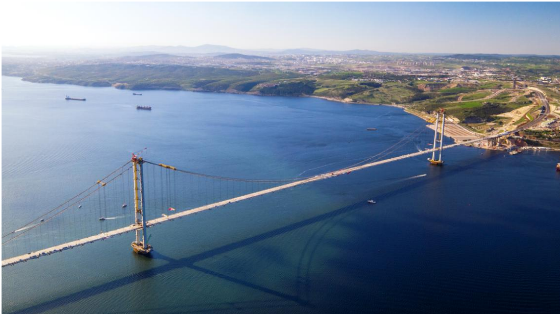
オスマン・ガーズィー橋全景（写真提供：株式会社 IHI インフラシステム）
